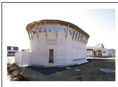
多目的ホール外観
